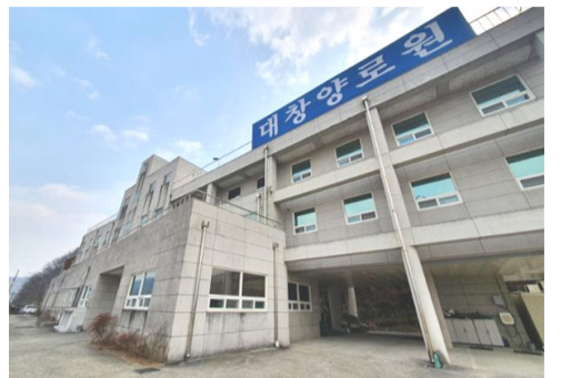
경북 고령군 대창양로원 전경. 류수현 기자
