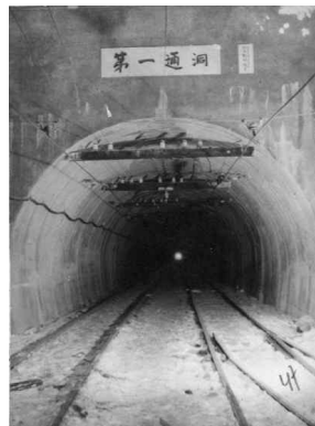
Главная штольня шахты в п. Быков
