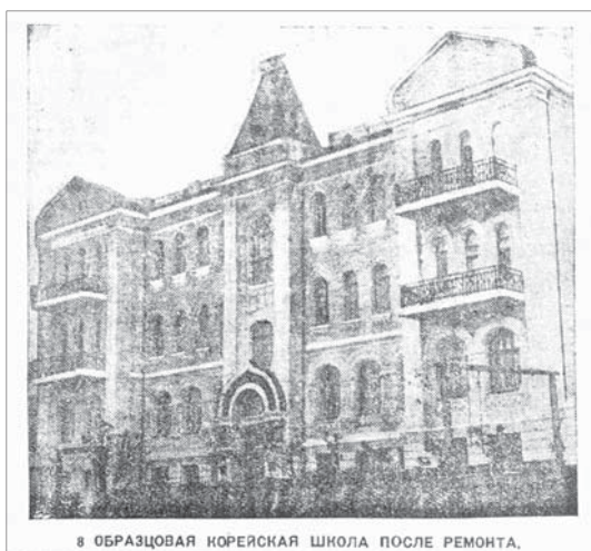
8 ОБРАЗЦОВАЯ КОРЕЙСКАЯ ШКОЛА ПОСЛЕ РЕМОНТА.
